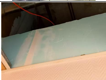
Photo n° PhA012 Localisation : Pièce 3 A; Pièce 6 ABD; Pièce 7 ABD; Pièce 8 AB; Pièce 9 AD ; Pièce 5 BD; Pièce 1 C; Pièce 10 D; Pièce 11 ABCD ; Pièce 12 ABC Ouvrage : 3 - Parois verticales intérieures - Murs et cloisons maçonnés Partie d'ouvrage : Joint d'assemblage Description : Joint d'assemblage carreaux de plâtres
