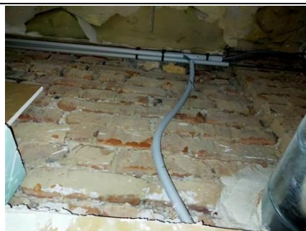
Photo n° PhA028 Localisation : Pièce 2A; Pièce 5A; Pièce 6D; Pièce 7B Ouvrage : 3 - Parois verticales intérieures - Murs et cloisons maçonnés Partie d'ouvrage : Joint d'assemblage Description : Mortier d'assemblage brique
