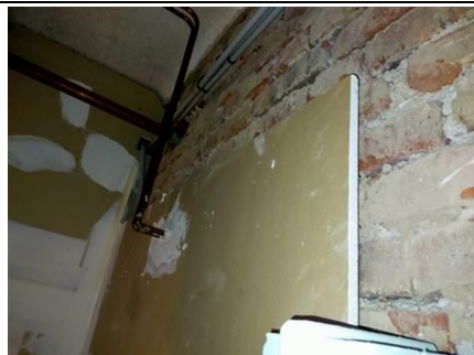
Photo n° PhA029 Localisation : Pièce 2A; Pièce 5A; Pièce 6D; Pièce 7B Ouvrage : 3 - Parois verticales intérieures - Cloisons sèches (assemblées, préfabriquées) Partie d'ouvrage : Plot de colle fixant les cloisons au mur Description : Plot de colle fixant les cloisons au mur
